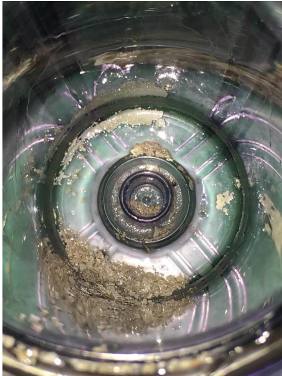
WSC系统过滤罐内水钙杂质
