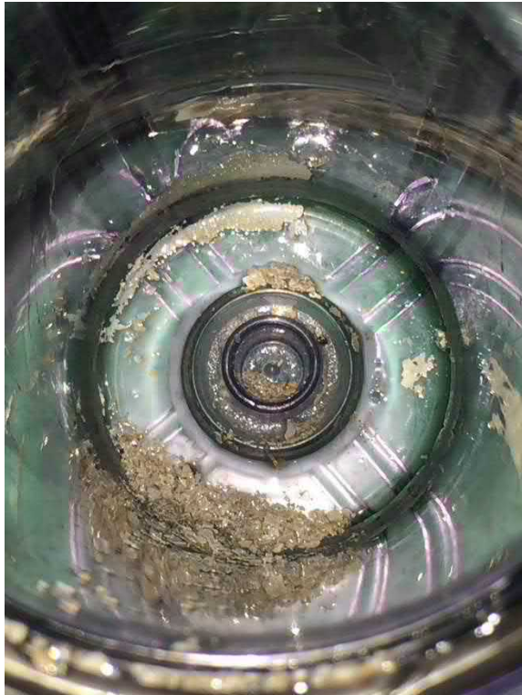
WSC系統過濾罐內水鈣雜質
